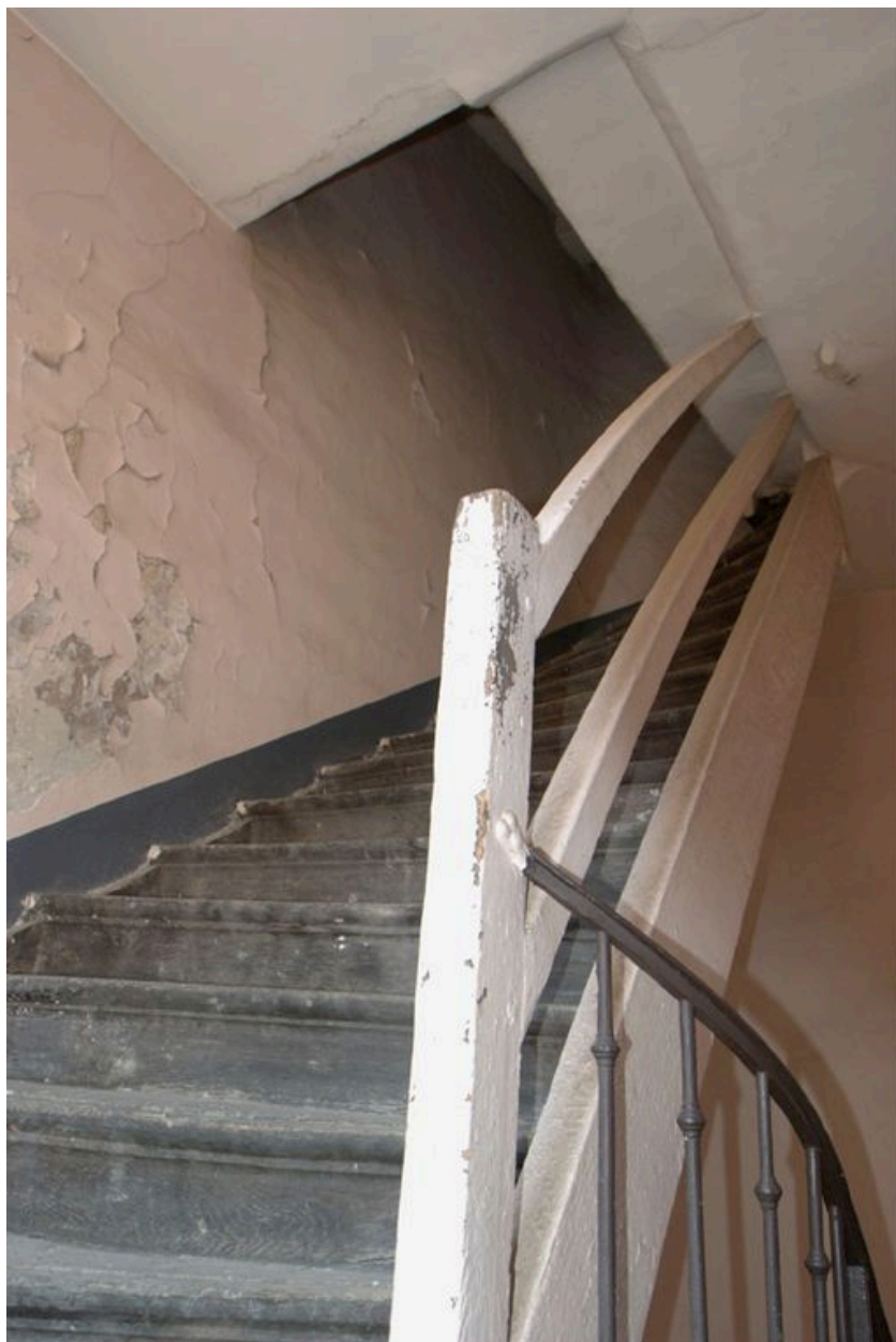
Vue de la dernière volée de l'escalier
