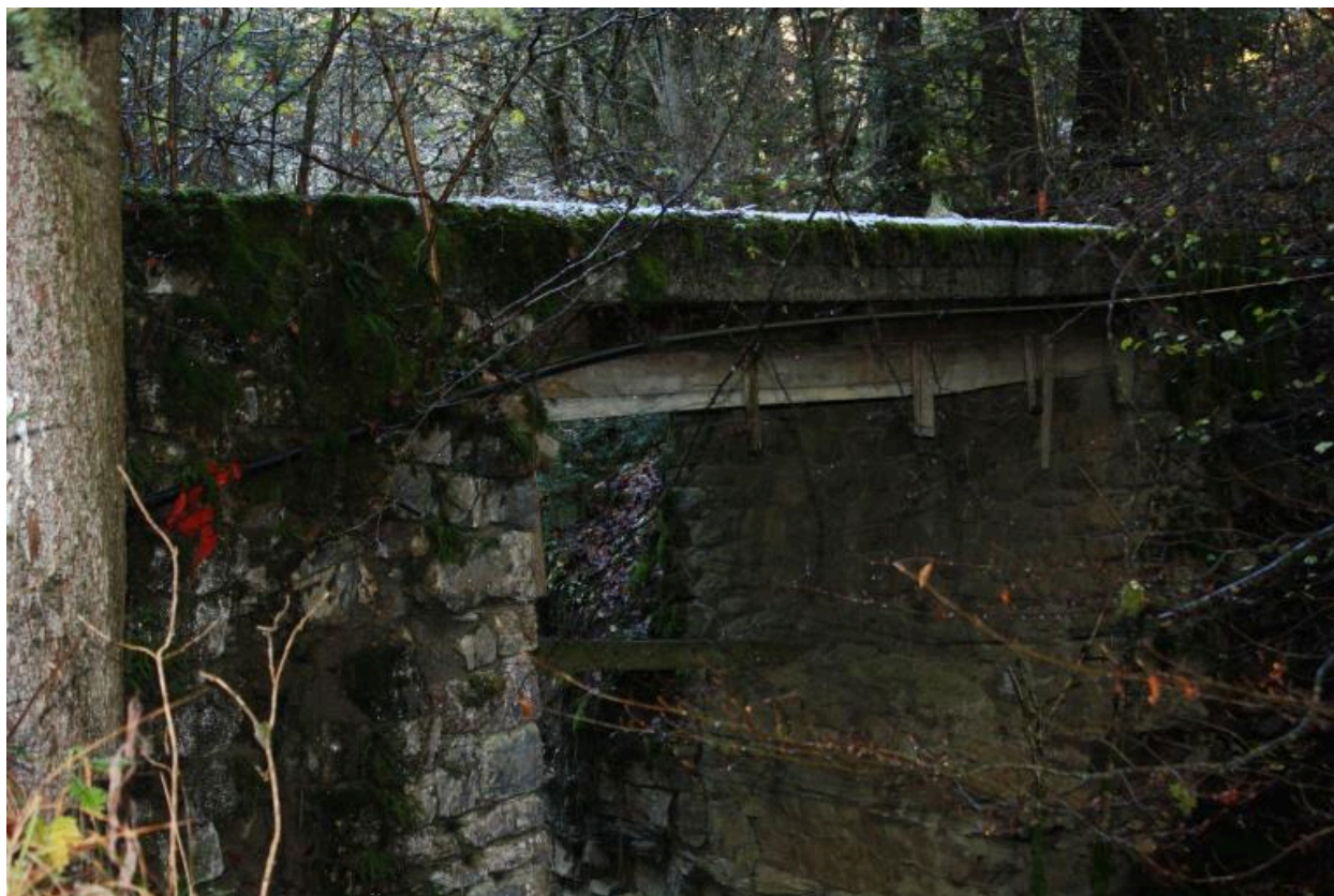
Vieux pont des Landoz, détails culée et tablier béton
