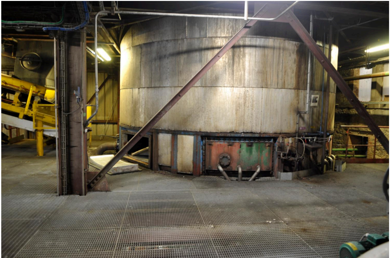
Vue de l'intérieur des ateliers
