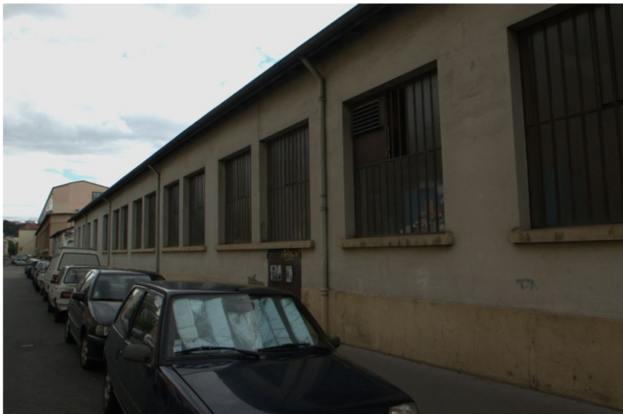
Détail façade, vue ouest
