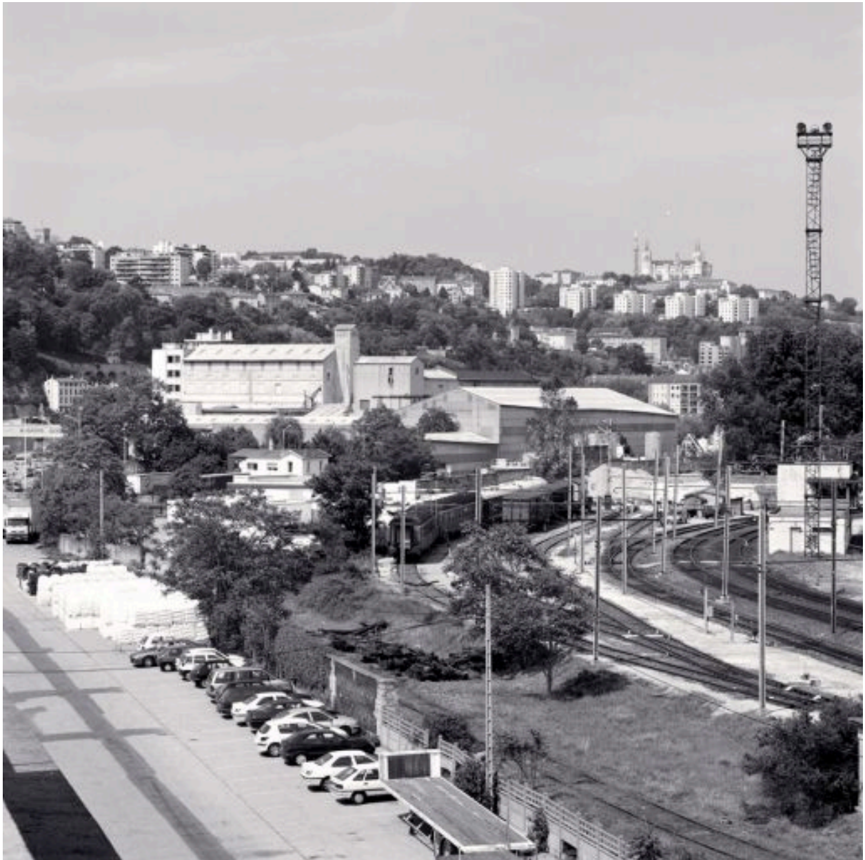
Vue d'ensemble depuis le toit de l'entrepôt des sucres, au sud
