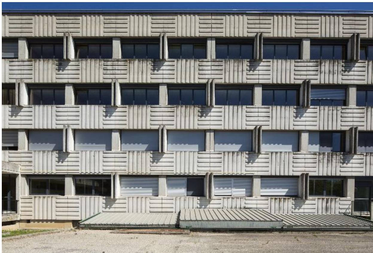
Bâtiment sud : jeu de façade et silos du chauffage au bois
