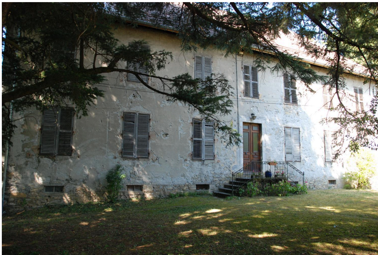
Vue de la façade antérieure.
