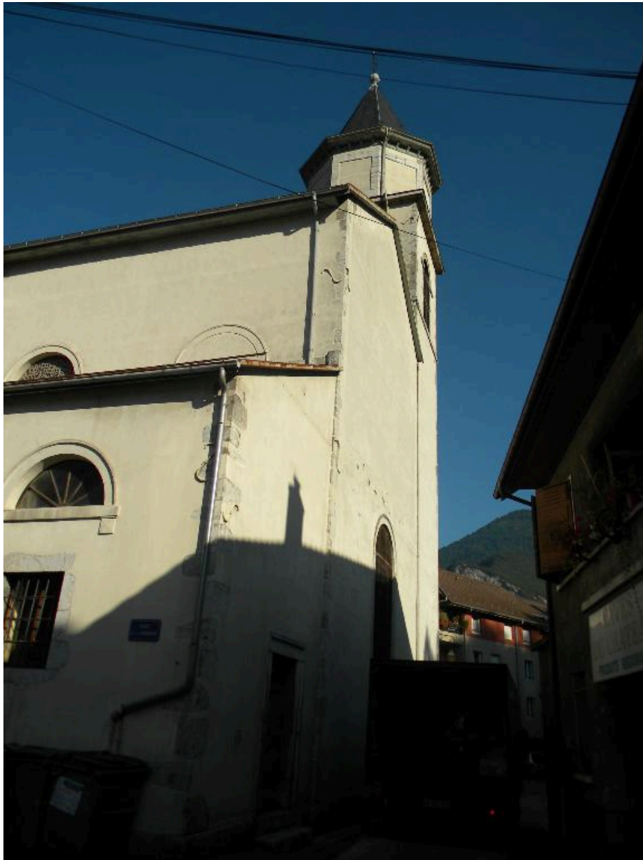
Vue de la façade arrière.
