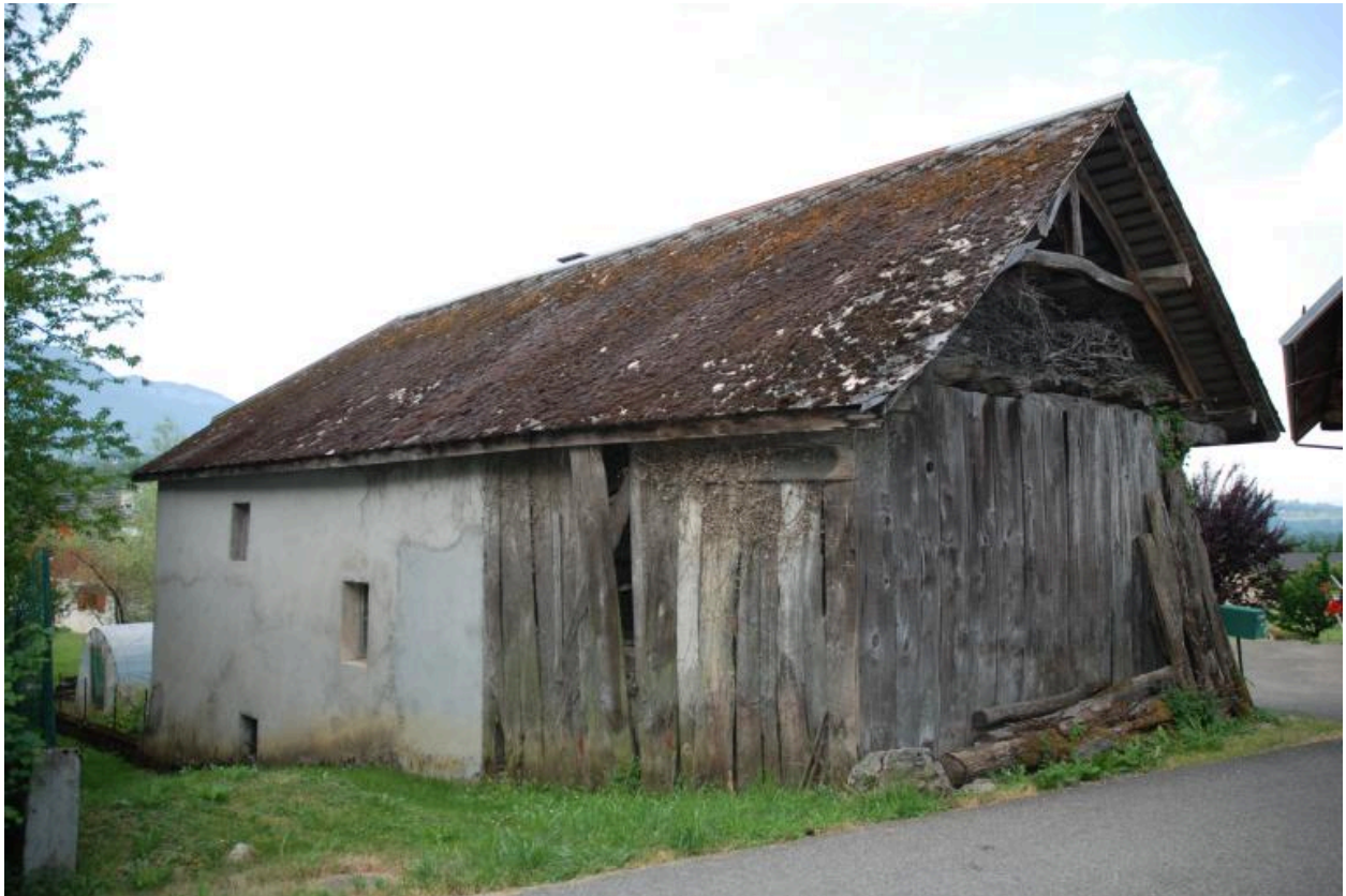
Vue arrière du bâtiment annexe.
