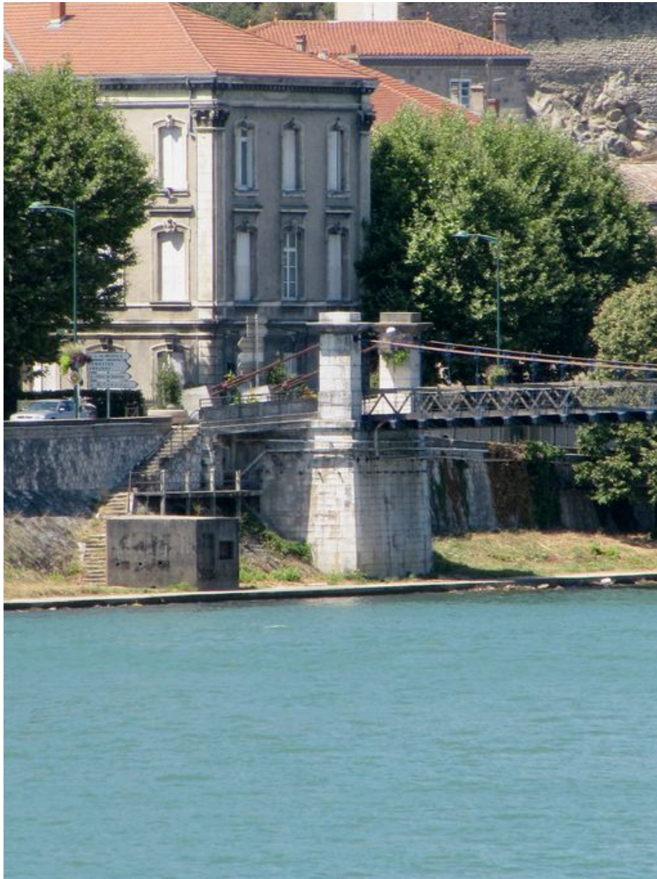
Vue partielle, culée droite, face aval (depuis le pont Toursier)
