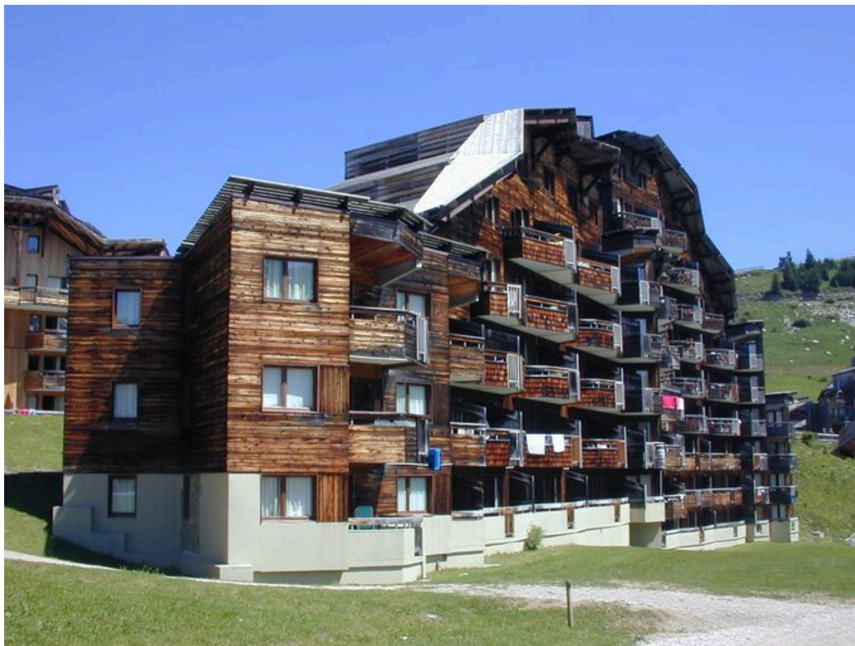
Elevation sud, depuis le sud-ouest
