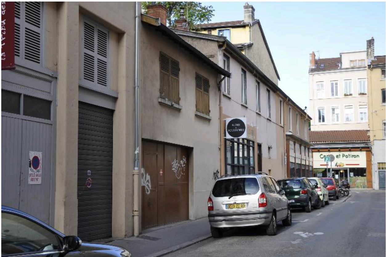
Vue d'ensemble nord est
