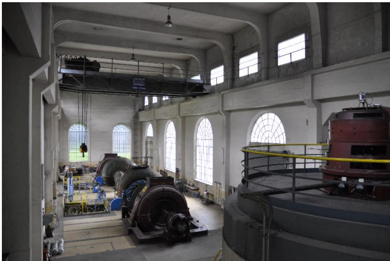
Vue d'ensemble du bâtiment des Clavaux à la charpente en béton
