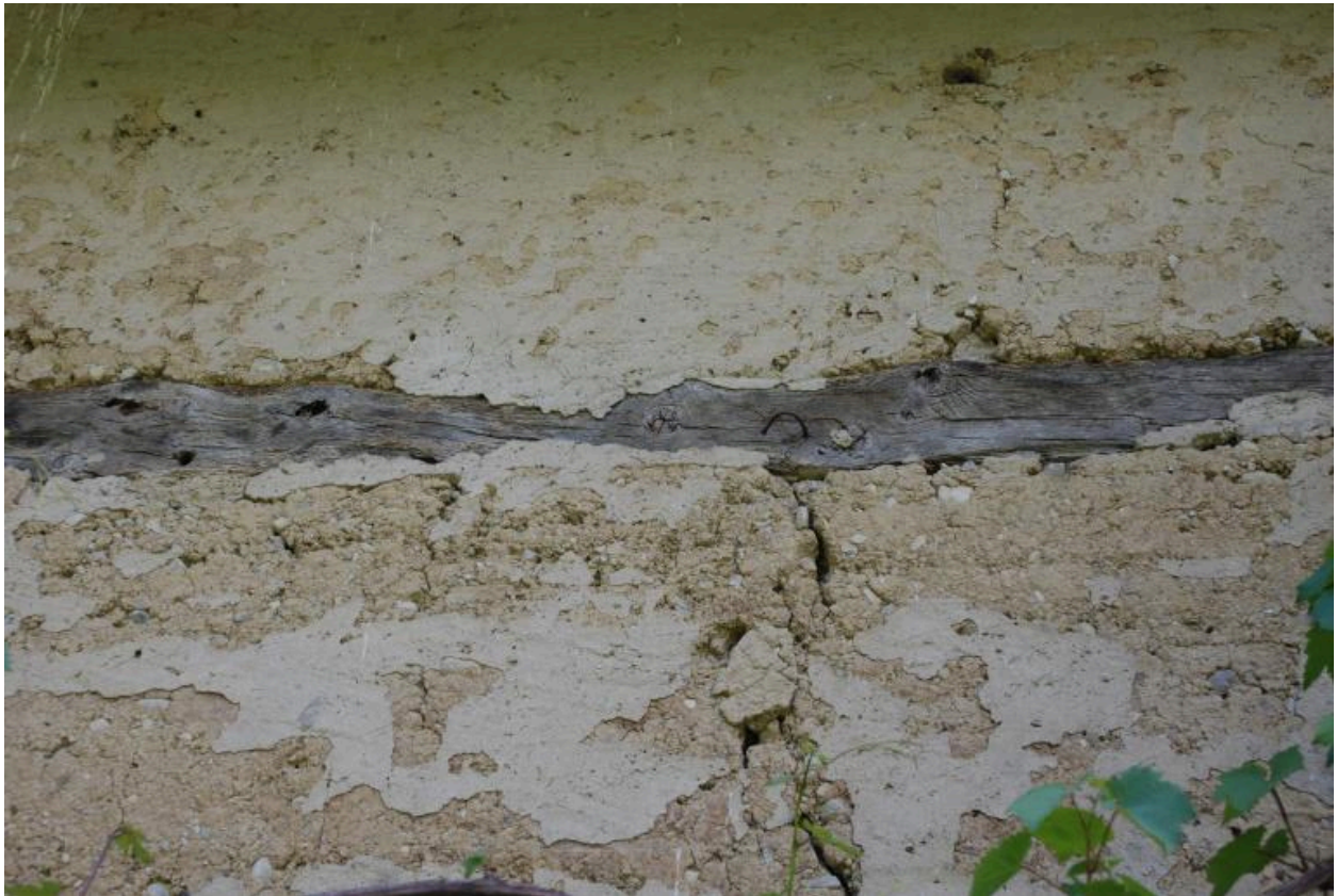
Détail de l'entrait pris dans le pisé, dernière ferme de charpente côté est.
