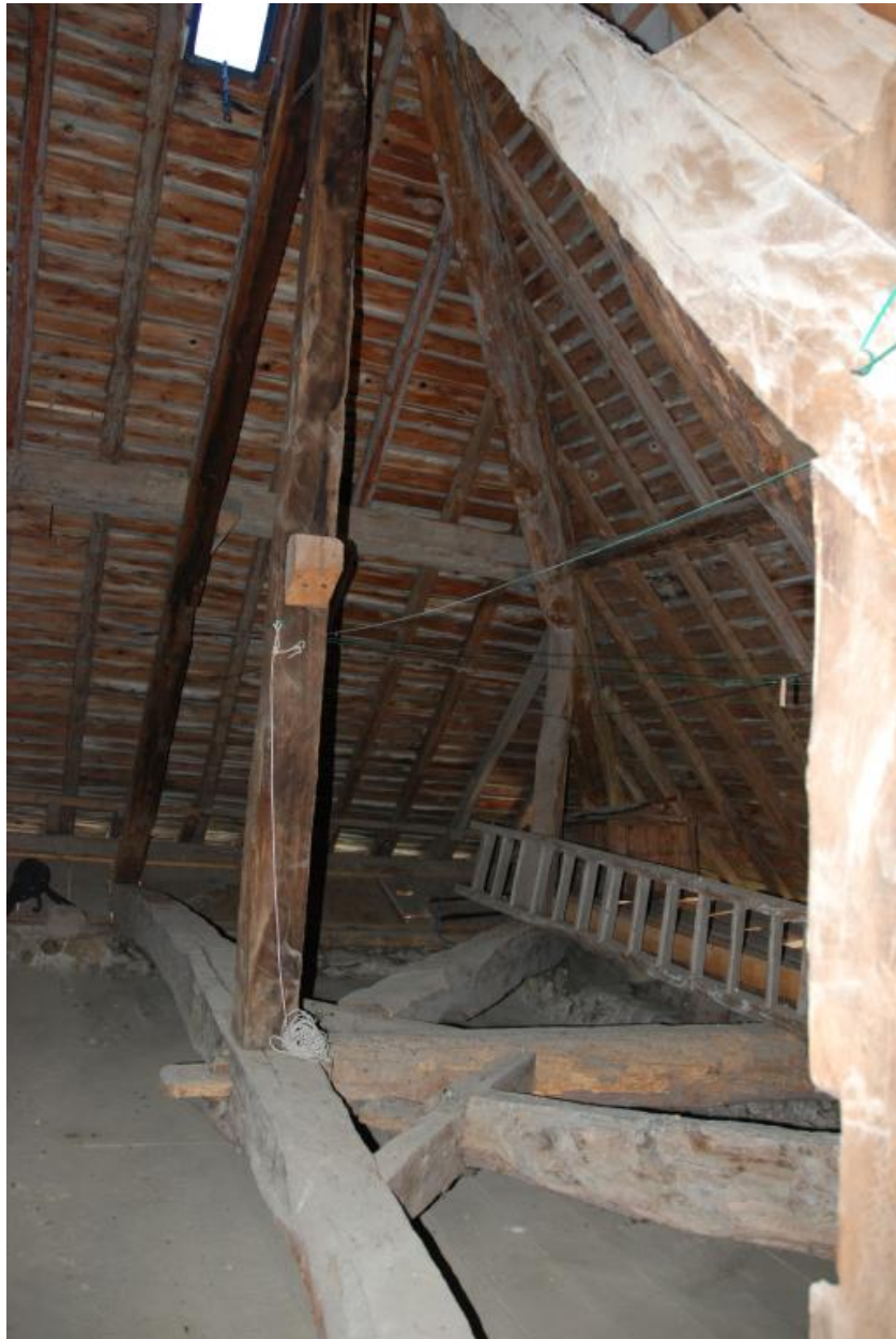
Vue intérieure de la charpente.
