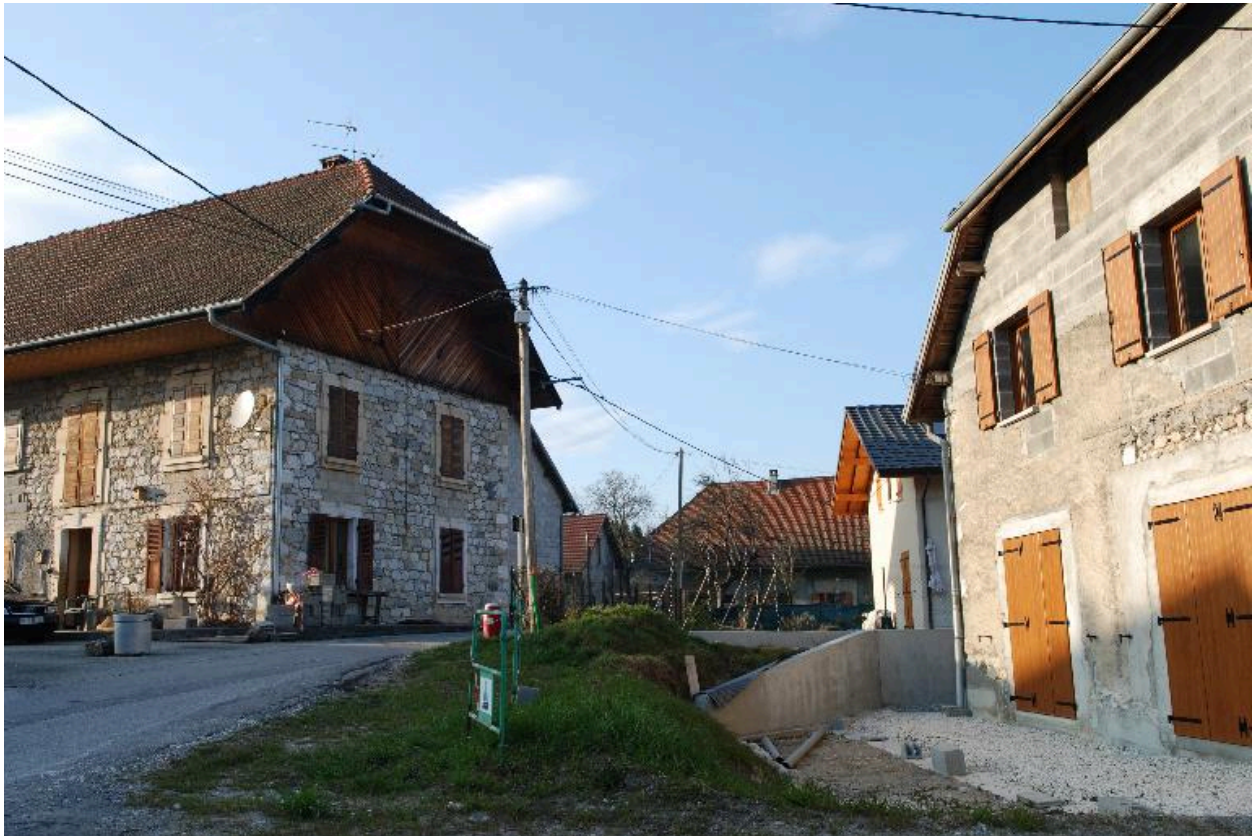
A3 282, Balevaz, maison ; A3 270, 271, ferme. Vue partielle des bâtiments voisins l'un de l'autre.
