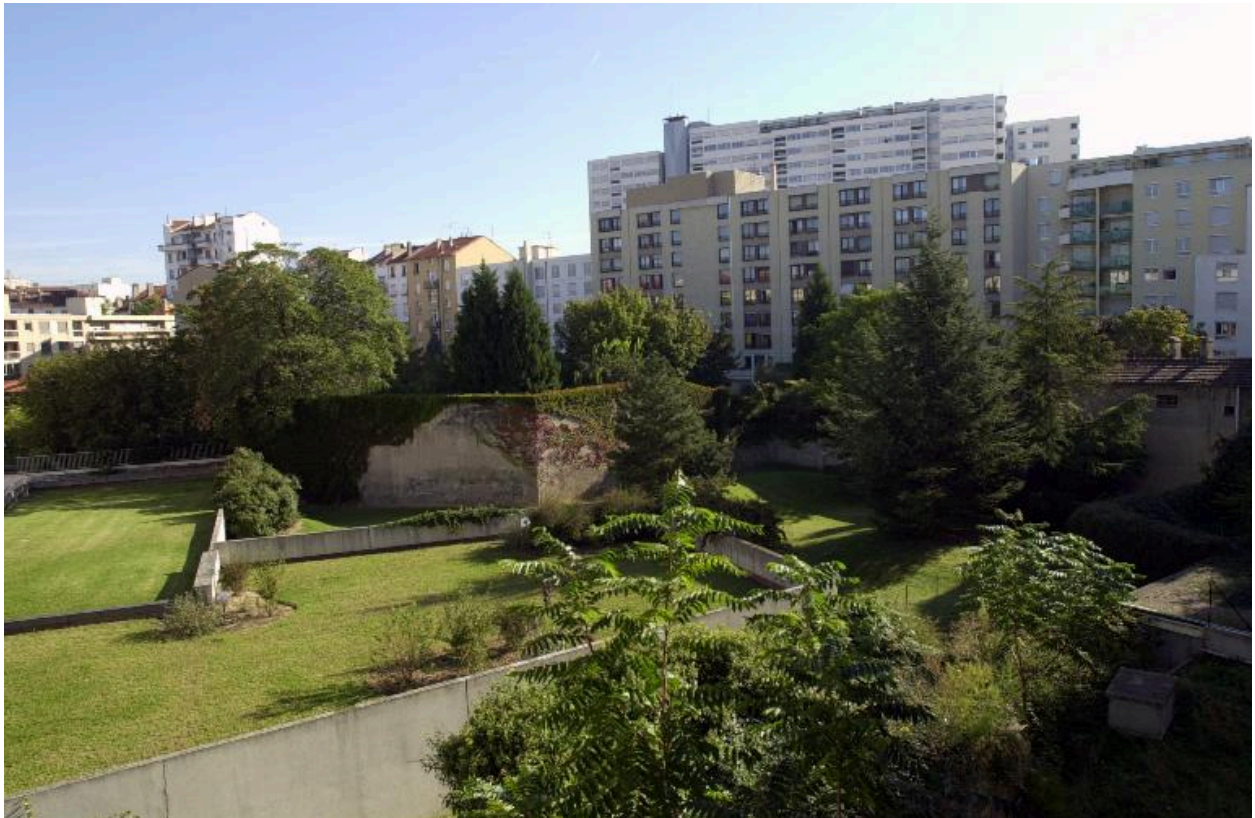
Vue générale depuis le sud-ouest
