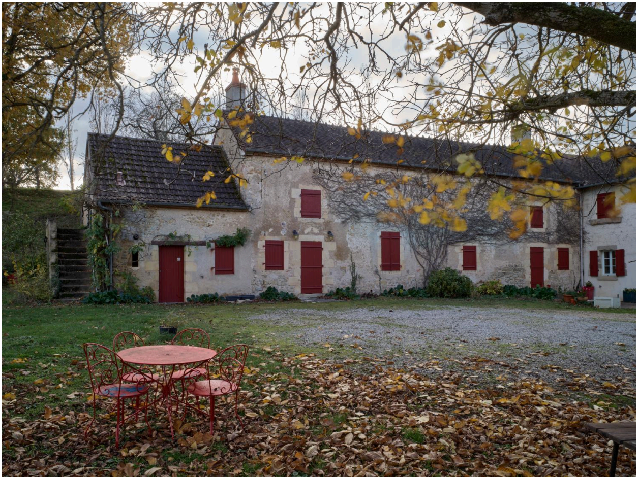
Bâtiment sud. Vue générale.
