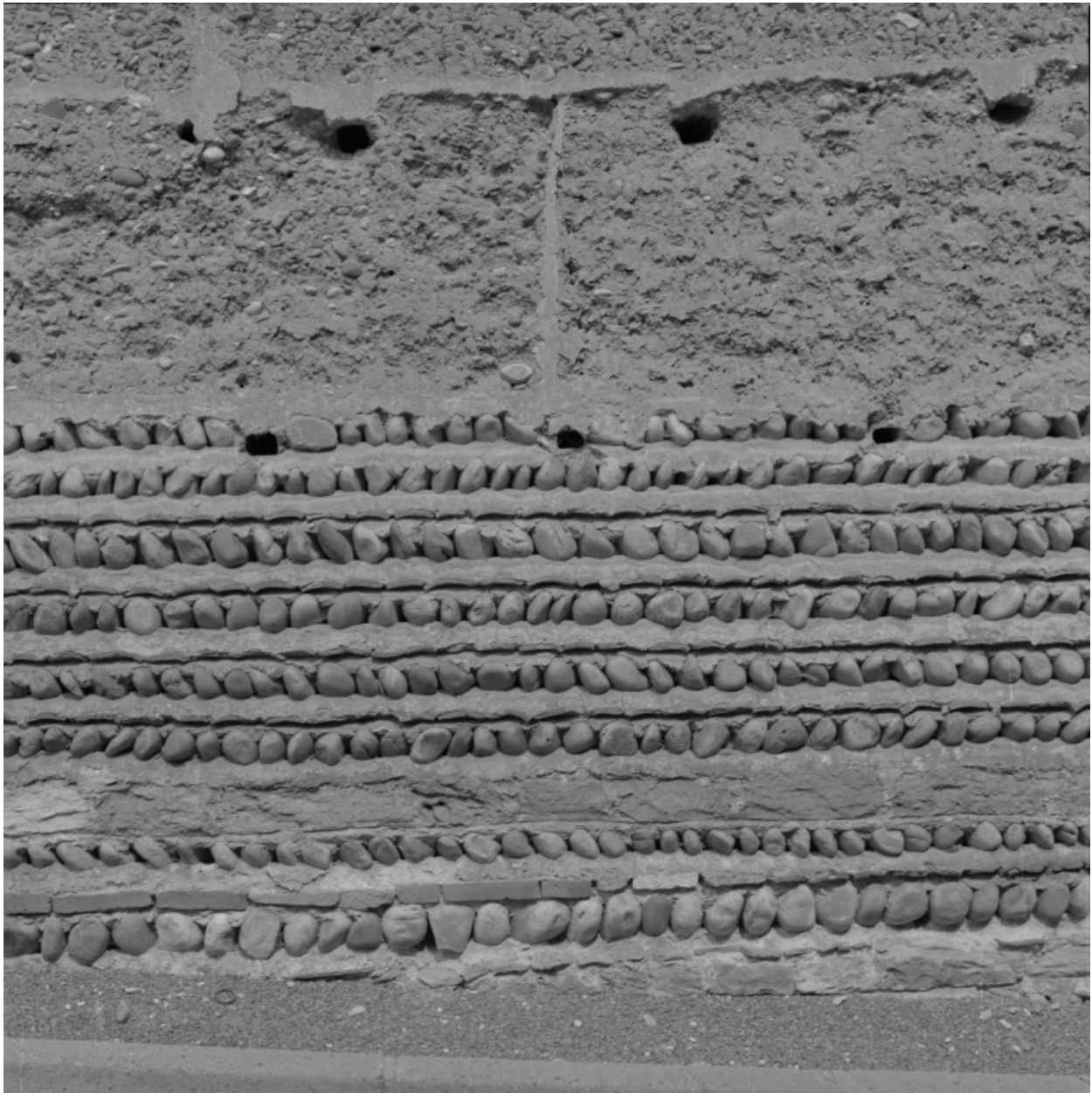
Ferme de type B, située sur la commune de Saint-Didier-de-Formans, au lieu dit le Berrier, parcelle B2 604. Mur de clôture, détail de mise en oeuvre des solins en brique et galet.
