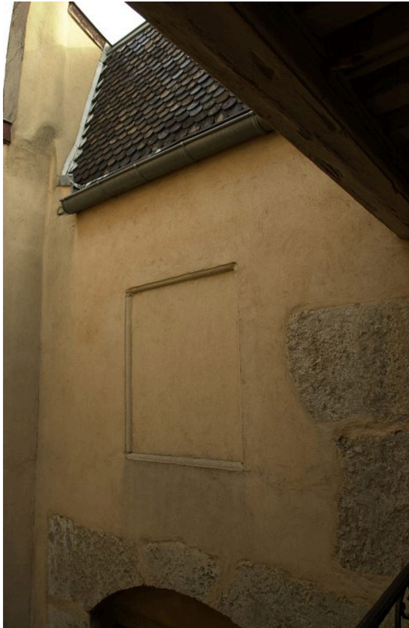
La cage d'escalier : dernier étage
