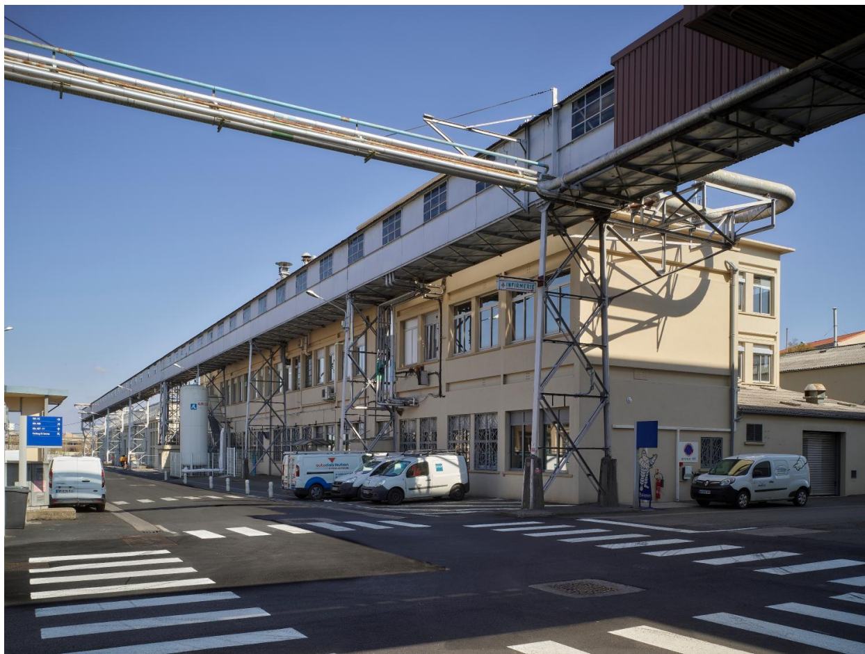
Passerelle technique à l'avant de l'élévation nord du bâtiment HE, rue de Saint-Sauves.
