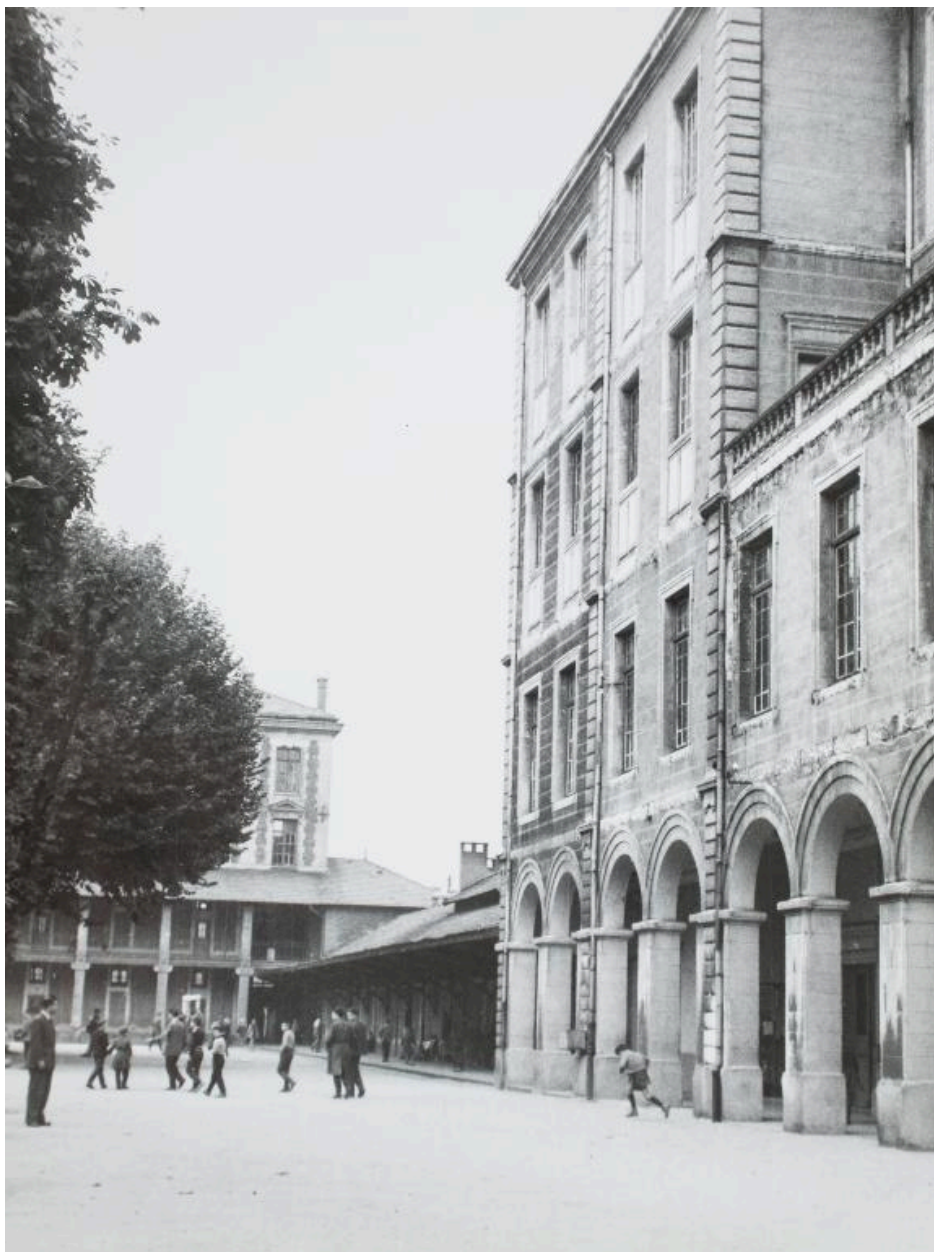
Vue des bâtiment H et A et du préau, vers 1950 (Arch. mun. Roanne, sans cote)
