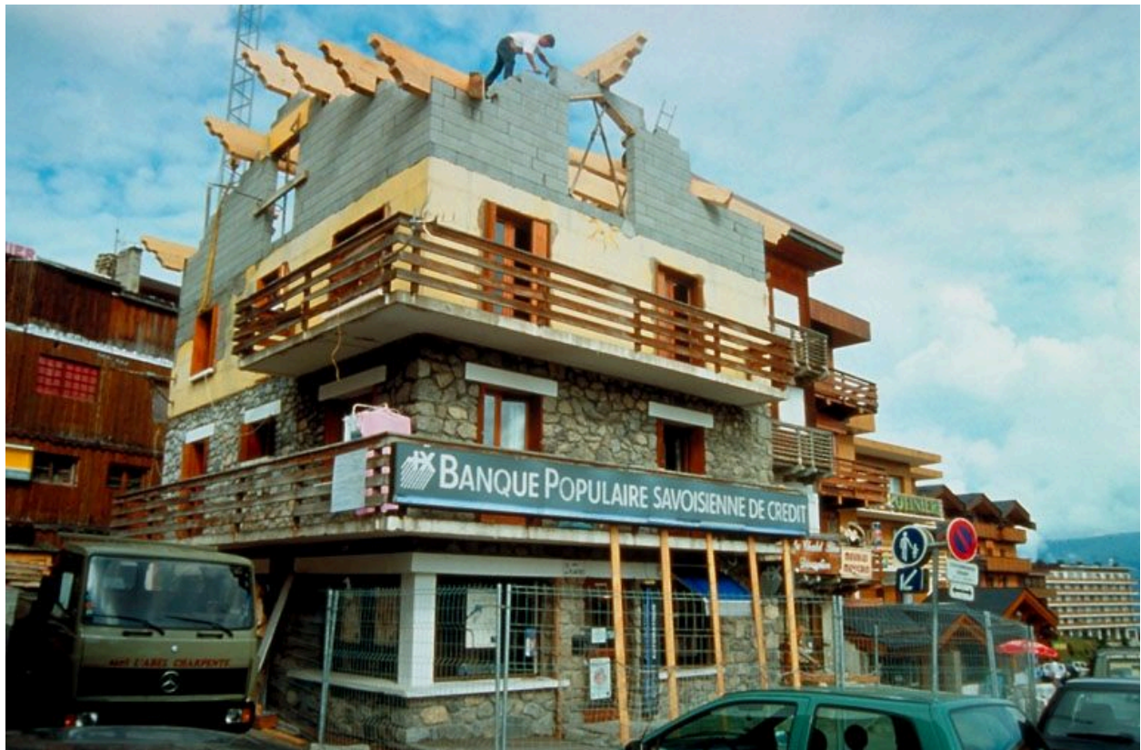
Elévation de 3/4 sud-ouest pendant les travaux
