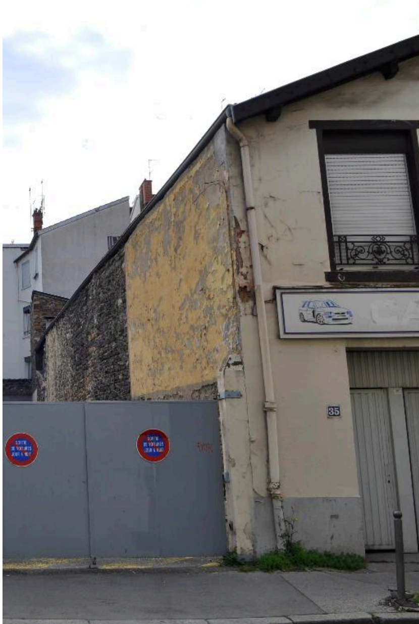
Atelier, élévation latérale nord en moellons apparents
