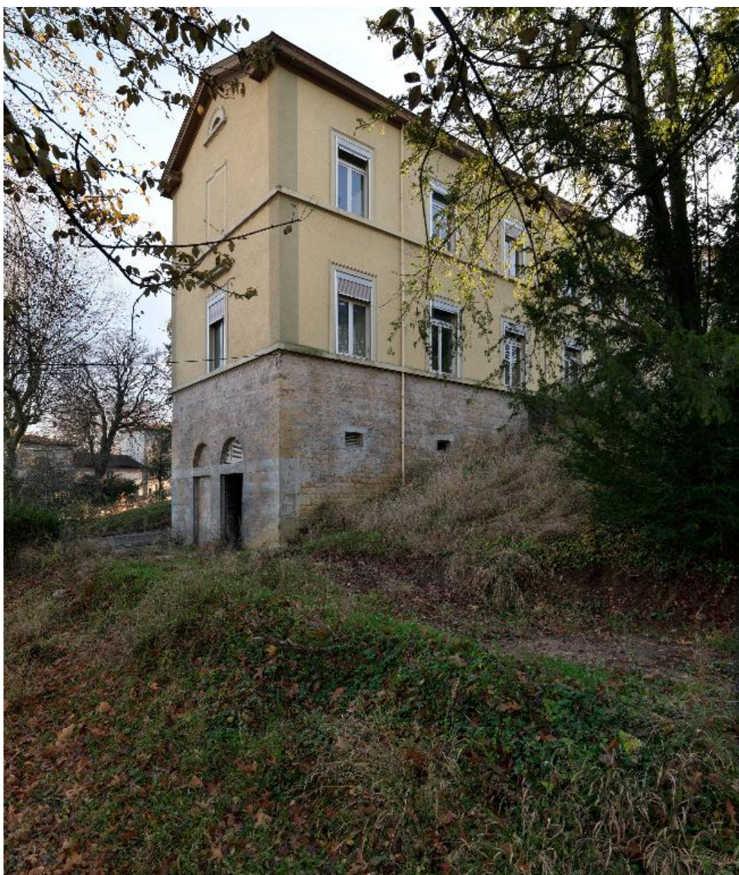
Bâtiment nord, dit "Hortensias", élévations nord et ouest, important soubassement en moellons calcaires
