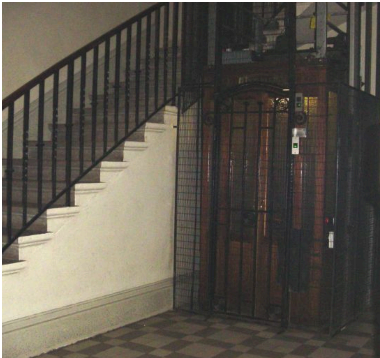
Ascenseur et départ de l'escalier
