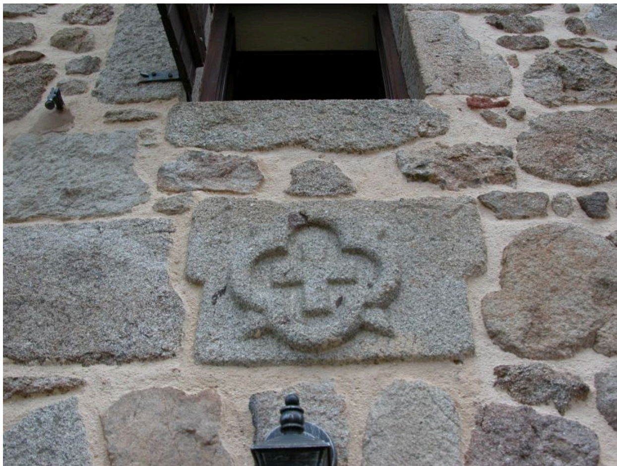
Détail d'un remploi sur la façade principale.
