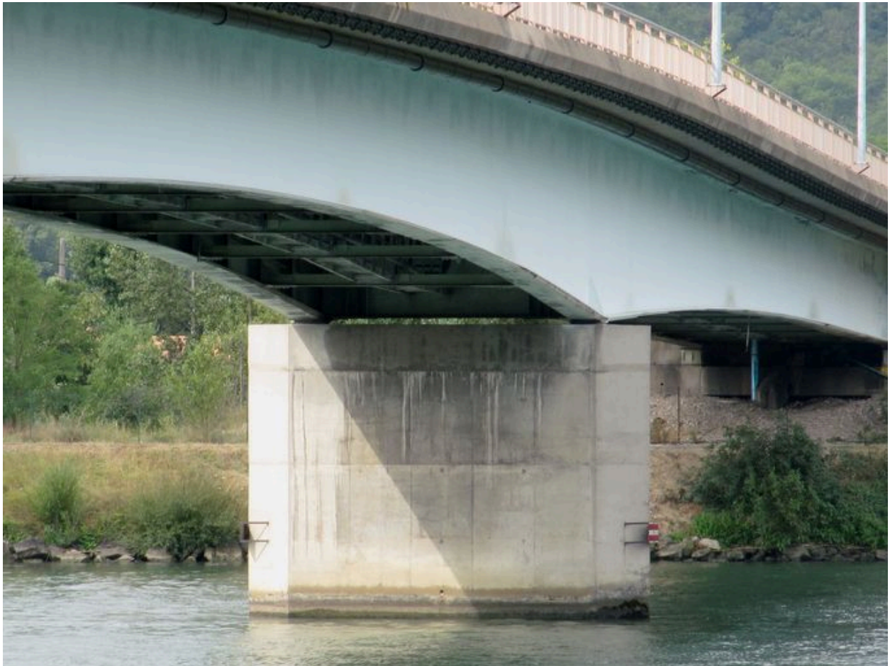
Pile, de côté, face amont, vue générale (depuis la rive gauche)
