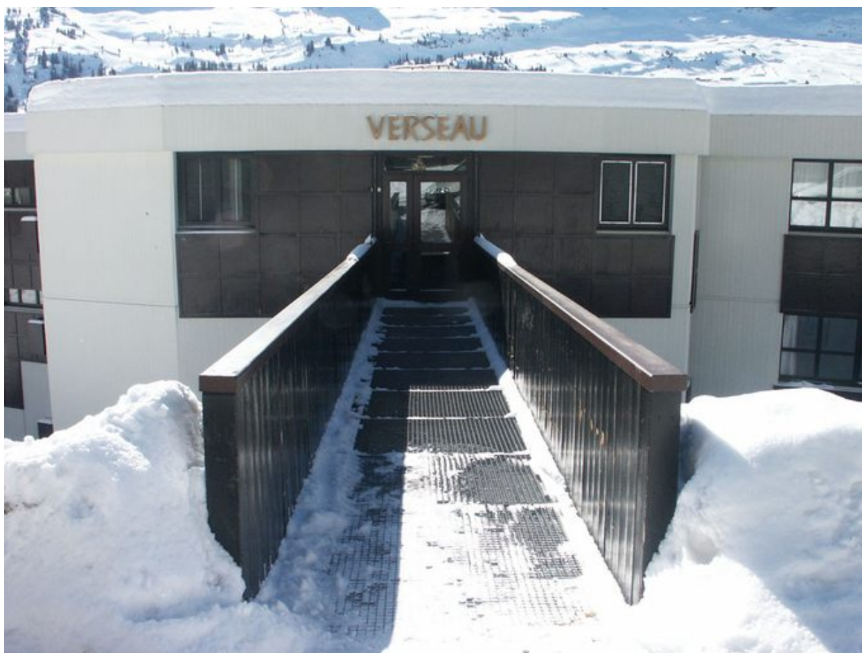
La passerelle d'accès
