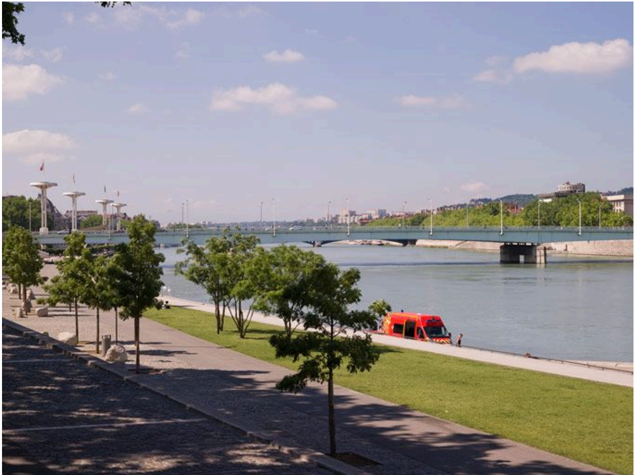
Le pont depuis le nord-est
