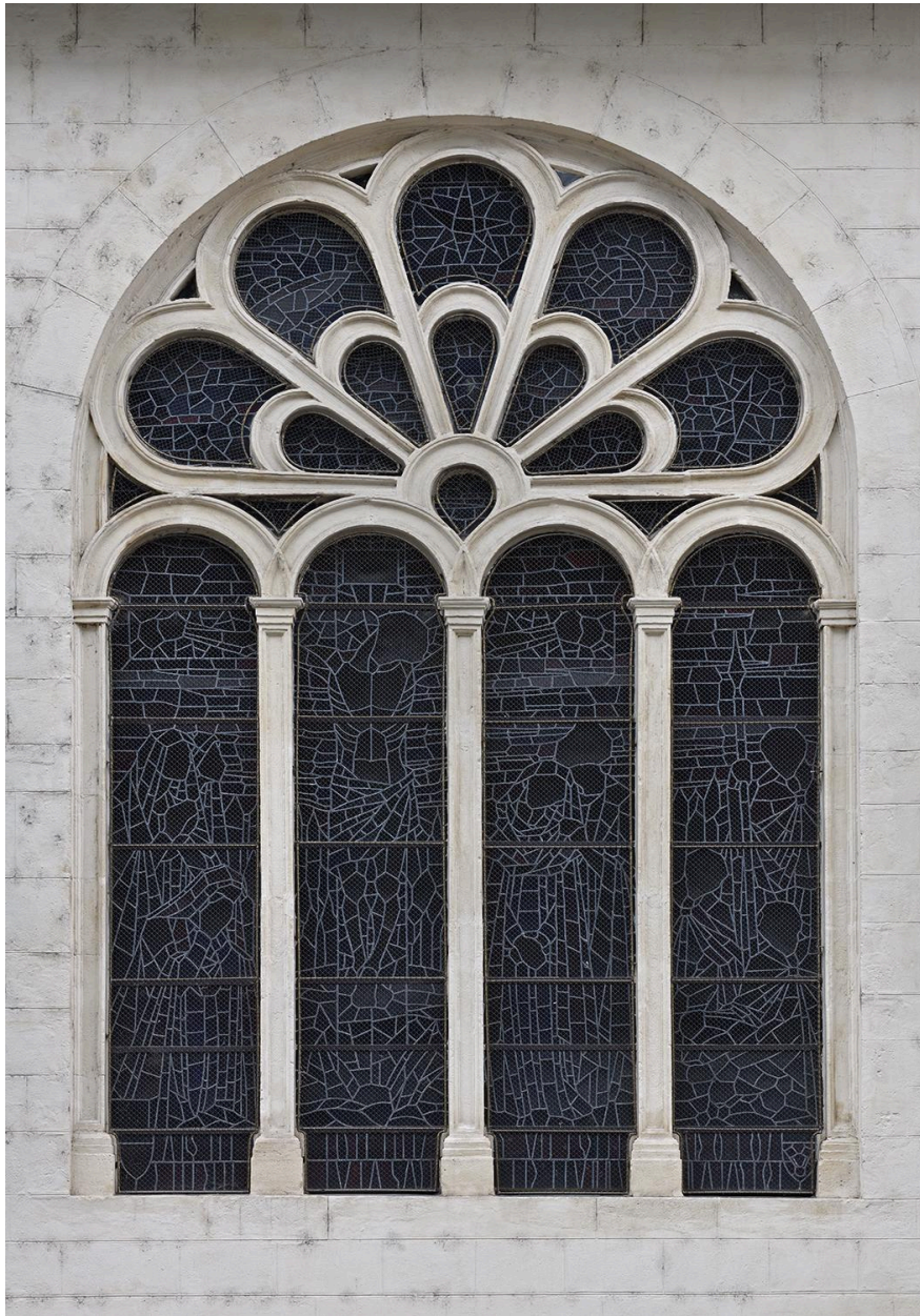
Elévation ouest, baie 2
