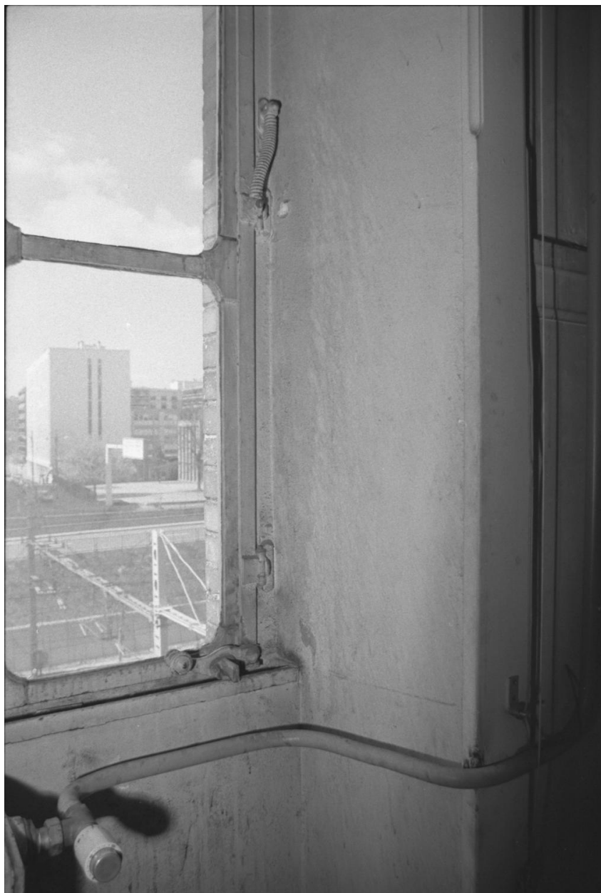
Poignée et loqueteaux de fenêtre. Pavillon CD, 1er étage, salle d'angle sud-ouest
