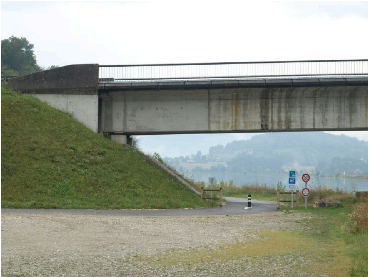
Culée, face amont : rive gauche
