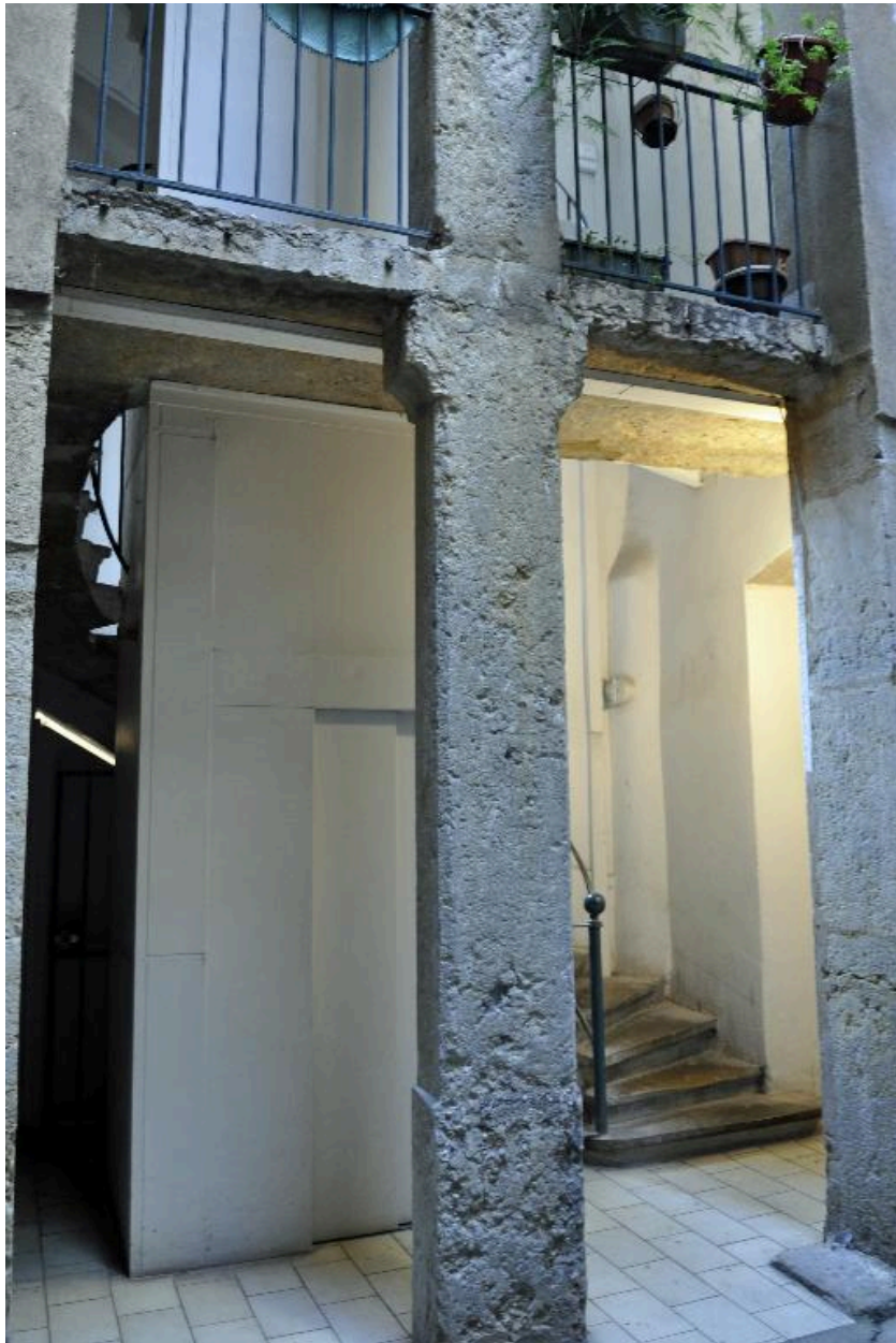
Escalier hors-oeuvre, mur de cage ajouré
