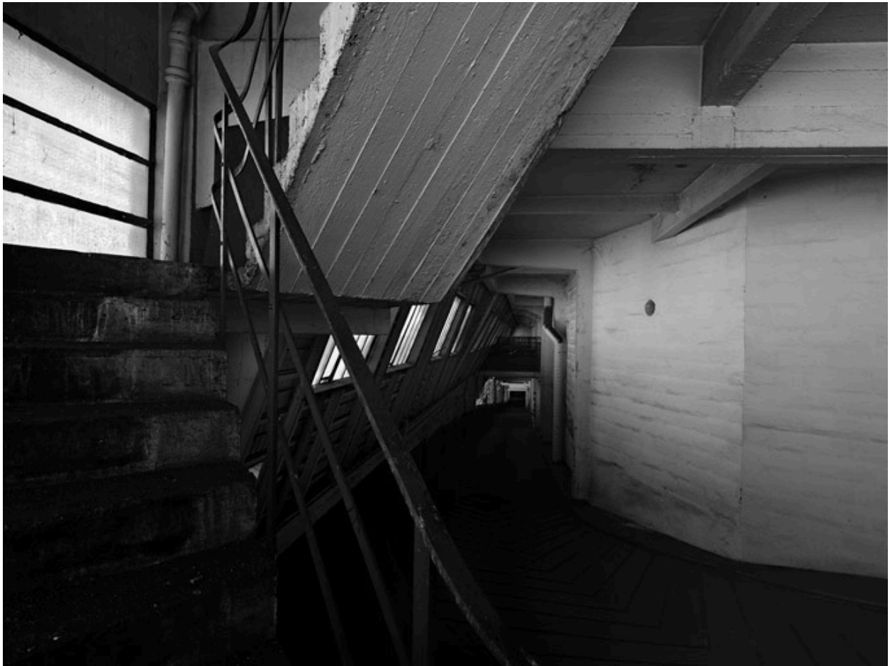
Escalier technique rampe montante
