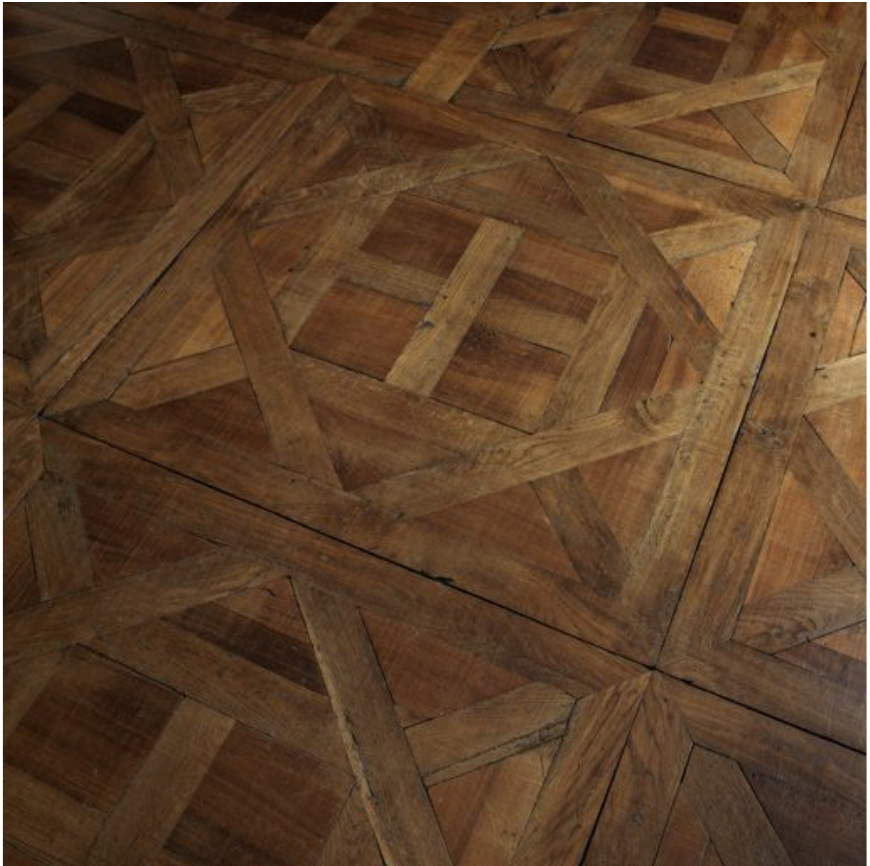
Appartement : détail d'un parquet
