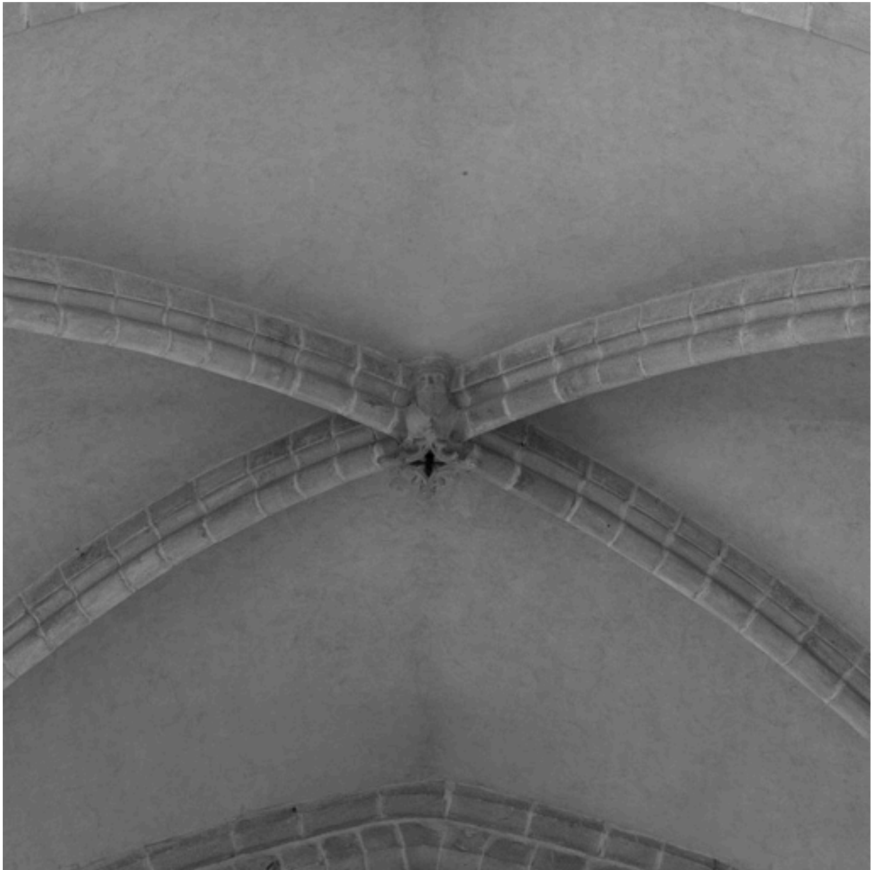
Détail de clef de voûte.
