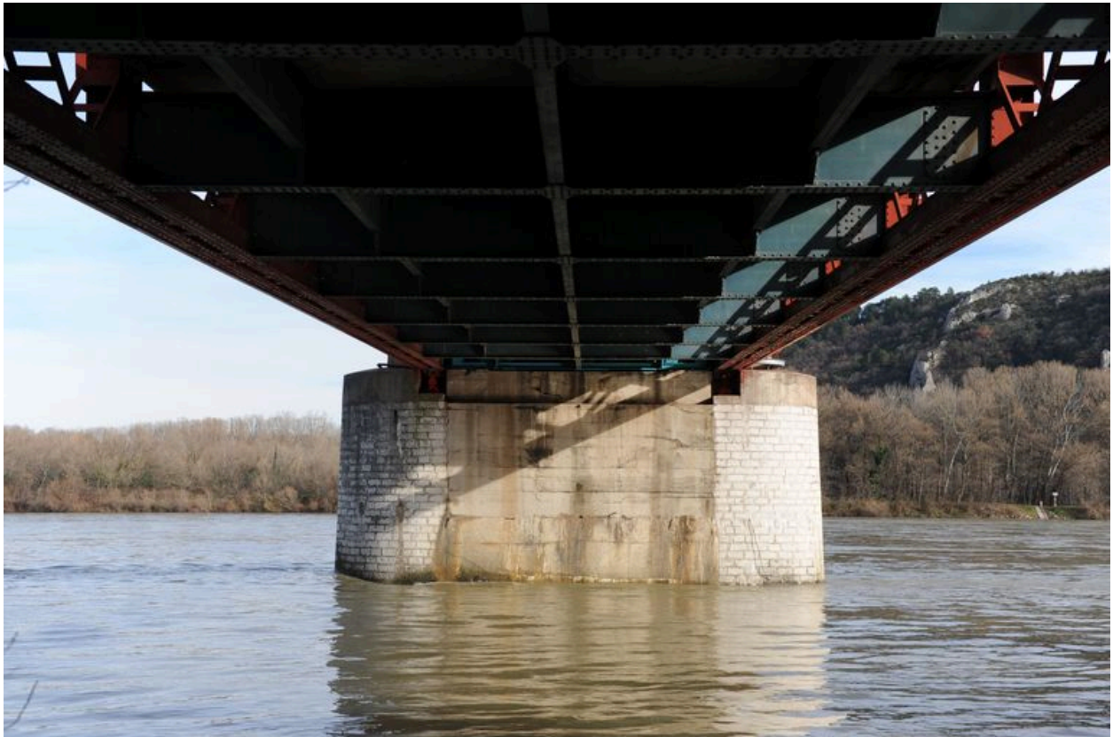
Vue partielle, de dessous, tablier et pile (depuis la rive droite)
