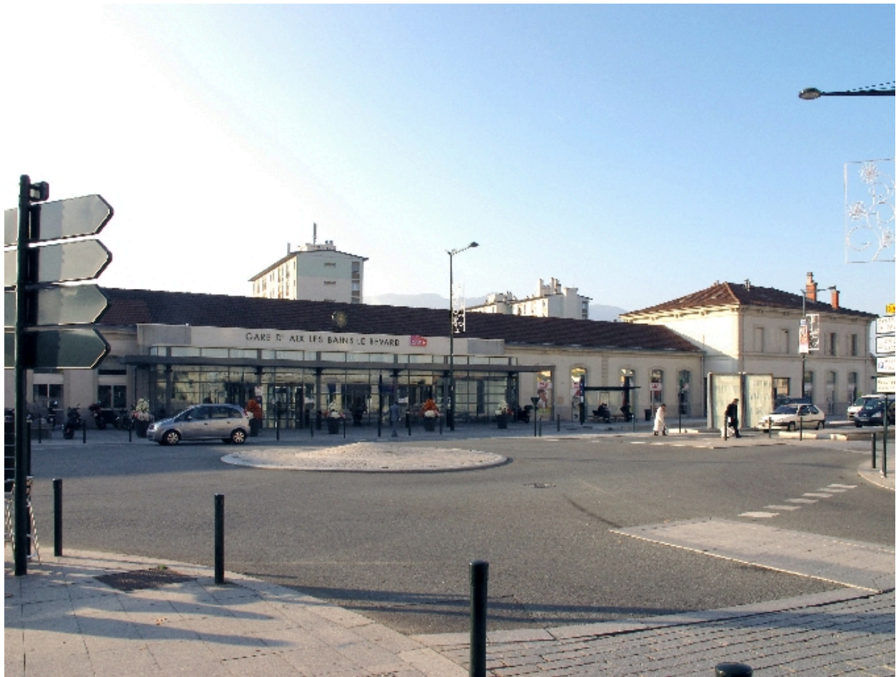
Elévations principales après les travaux de 2010
