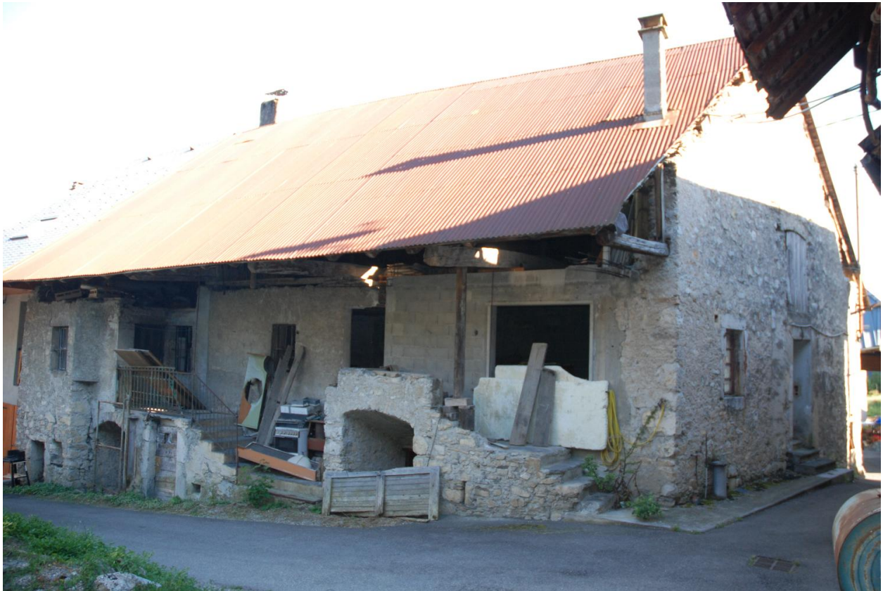
Maisons de vigneron (2018 I1 1769, 1663, 136), vue nord.
