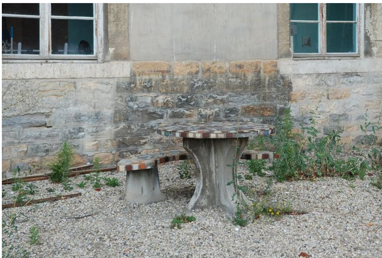
Façade postérieure : partie inférieure du mur en moellons apparents et mobilier de jardin en béton et mosaïques réalisé par des patients (art-thérapie)
