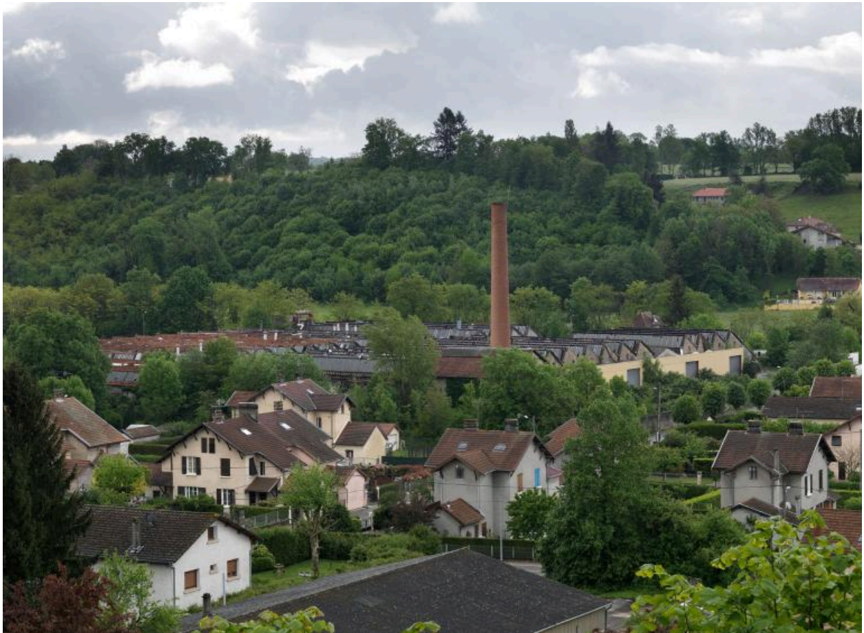
Vue d'ensemble du site de la corderie
