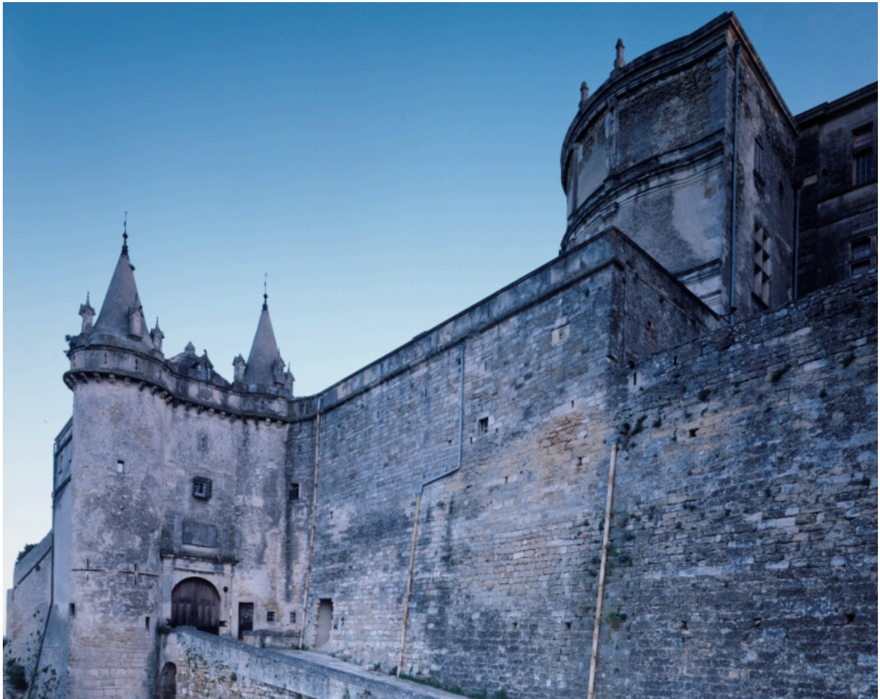
Bâtiment d'entrée. Vue générale avec la tour sud-ouest du château, prise depuis la Planette.
