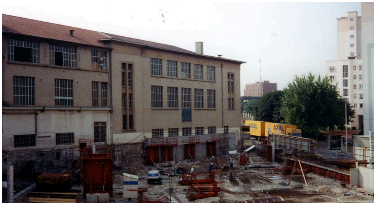
Vue des travaux de la cour vers le sud est, septembre 1993
