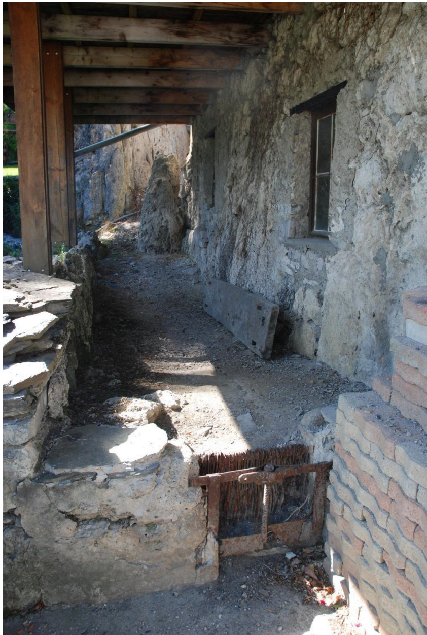
Passage de l'ancien bief, au pied de la façade.
