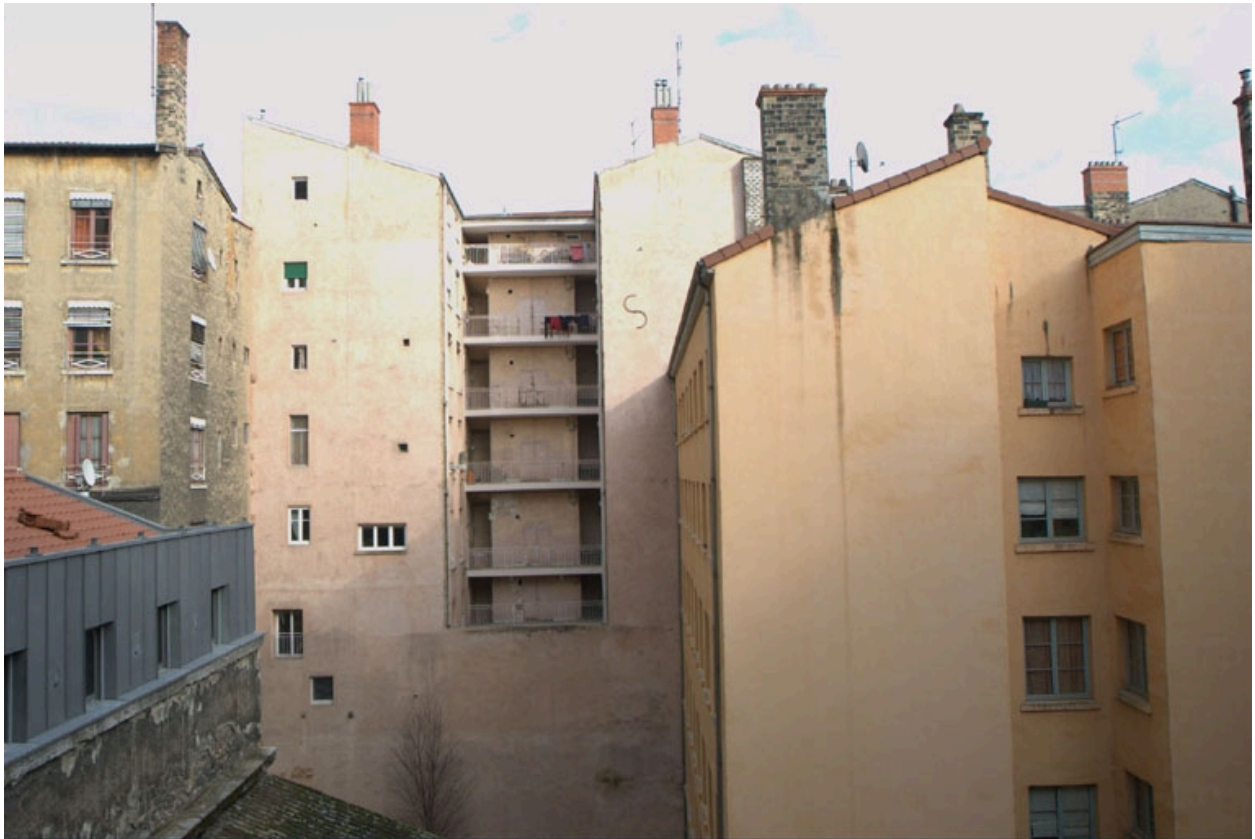
Vue de l'environnement directe de cet atelier, en coeur d'îlot
