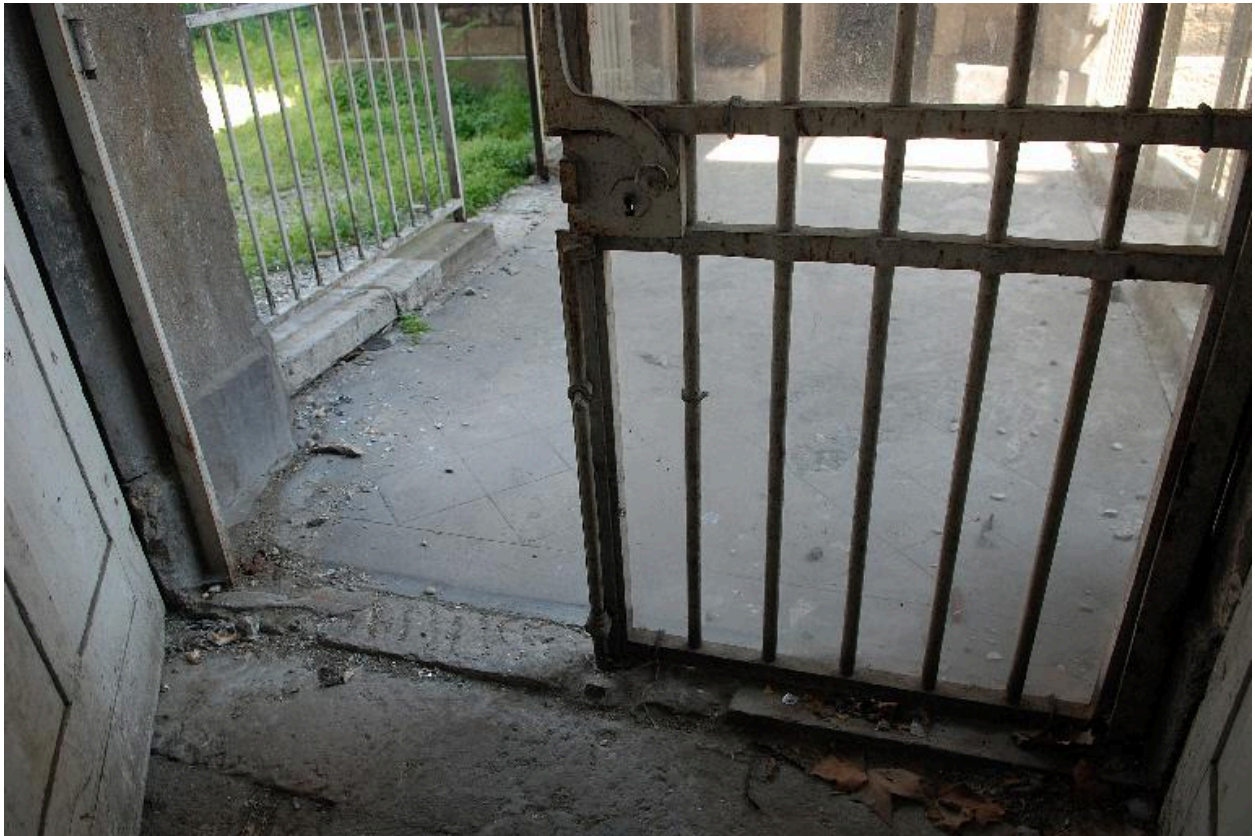
Etat en 2010 : détail d'une grille
