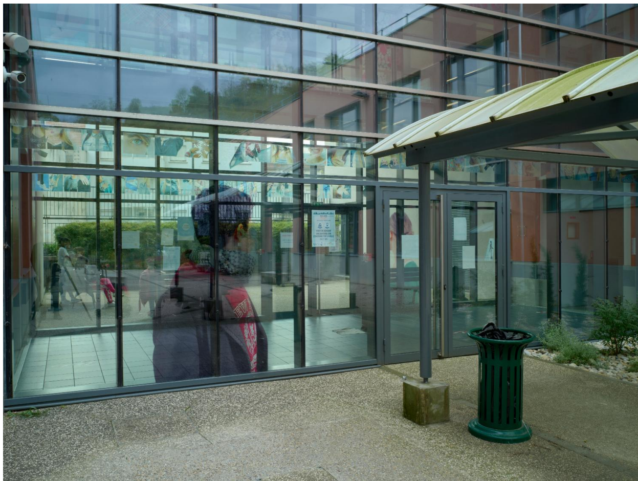
Passerelle : niveau inférieur, vue depuis l'accès extérieur.
