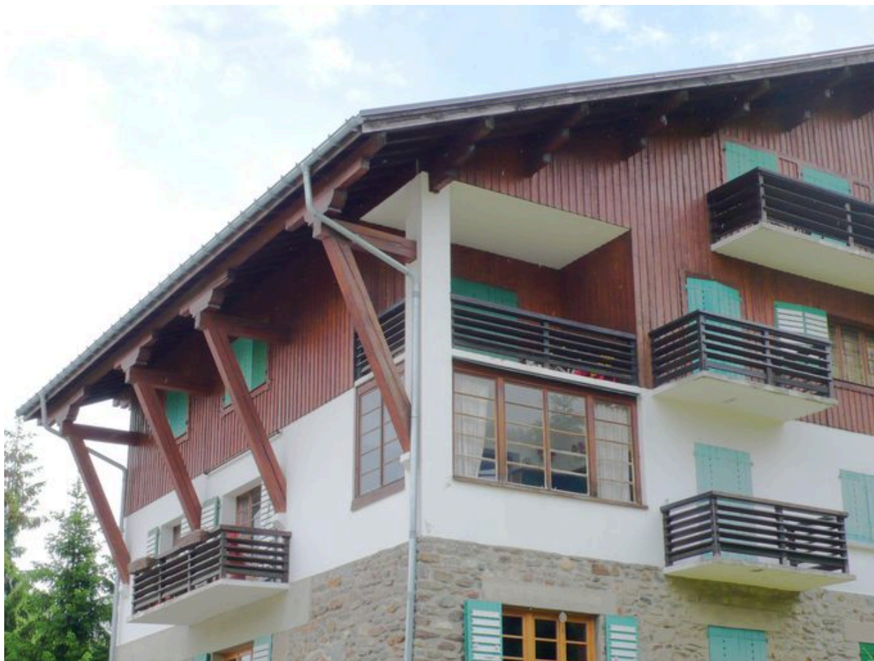
Vue de la fenêtre d'angle au sud-ouest
