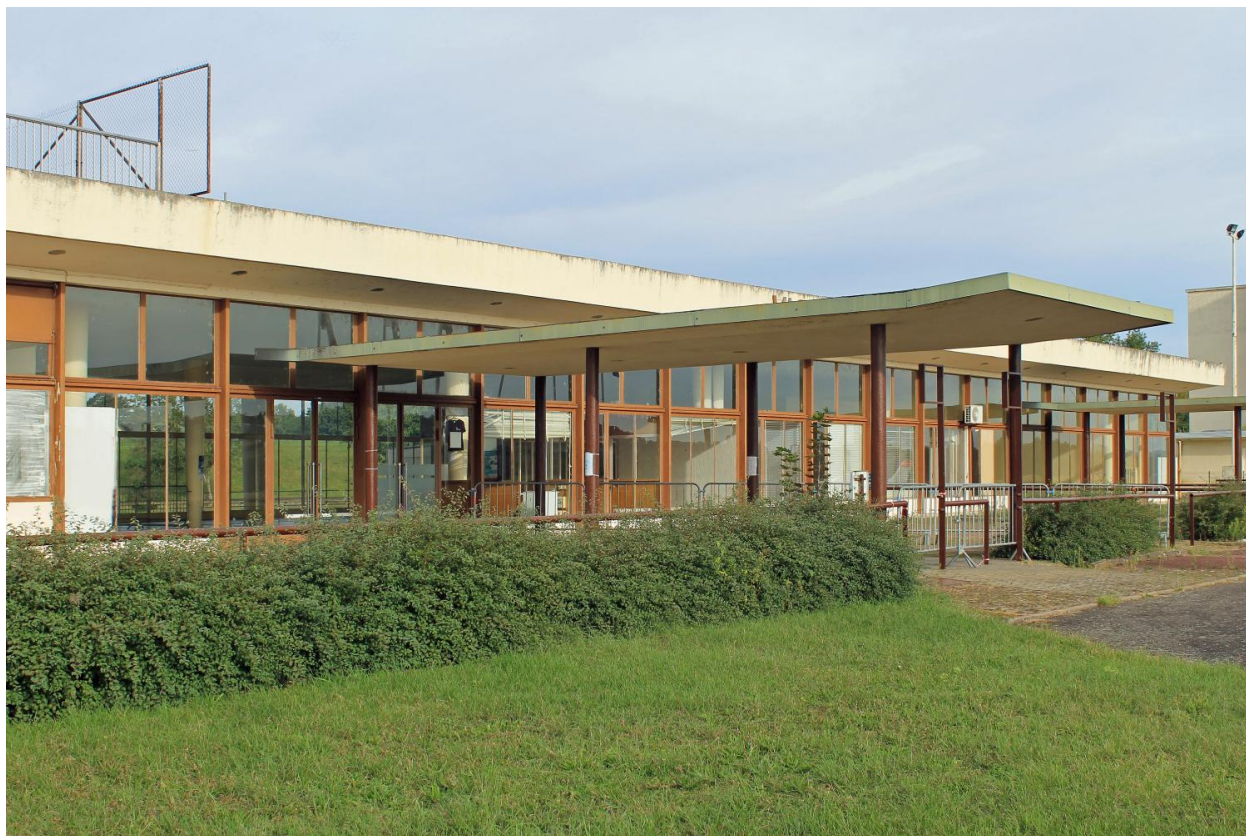
Détail d'un auvent en façade sud de l'aérogare de Vichy-Charmeil.
